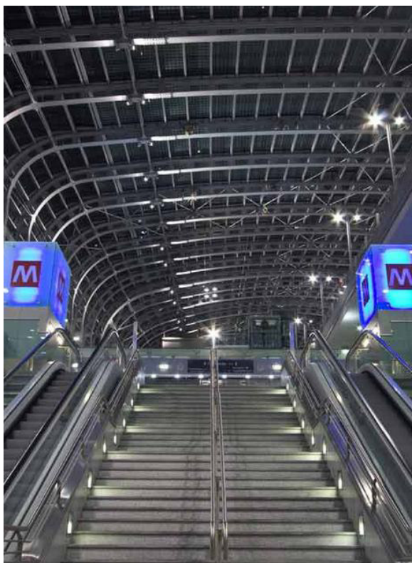
fig. III.1.5.3.1 – Immagine di un corpo scala di collegamento fra l'atrio della stazione di Torino Porta Susa e la Metropolitana Automatica di Torino. I segnapasso sono realizzati utilizzando apparecchi illuminanti a LED rettangolari di medie dimensioni posti in prossimità dei gradini ad una distanza di circa 1,5 metri l'uno dall'altro. Apparecchi da incasso di dimensioni più piccole possono essere installati ad una interdistanza minore (generalmente un apparecchio ogni tre gradini). La presenza dei segnapasso favorisce l'individuazione dei gradini grazie all'aumento del contrasto di luminanza fra i gradini stessi della scala (fonte Internet)
