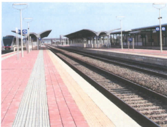
Stazione di San Gavino: pavimentazione in masselli autobloccanti cls
