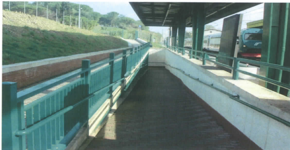
Stazione di "Villa Bonelli", particolare della rampa per disabili di accesso al sottopasso di stazione
