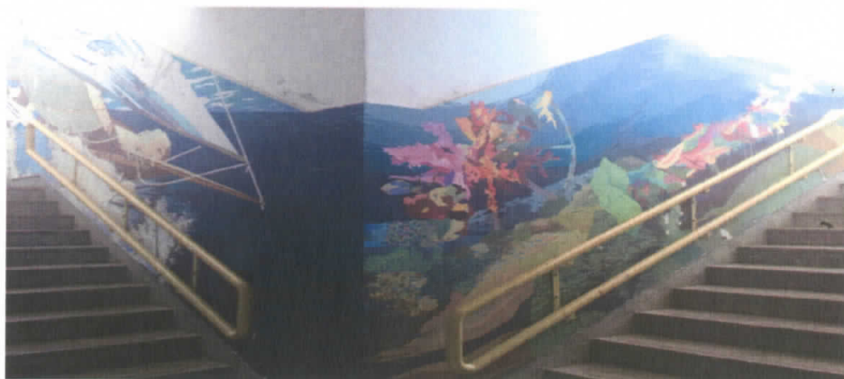
Alcuni esempi di scale di accesso al sottopasso di stazione con il doppio corrimano come previsto dalle STI PRM.
