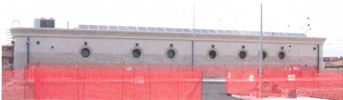
Linea Messina-Palermo, stazione di Campofelice (PA): realizzazione dell'impianto fotovoltaico sulla copertura del Fabbricato Tecnologico di stazione (febbraio 2014)
