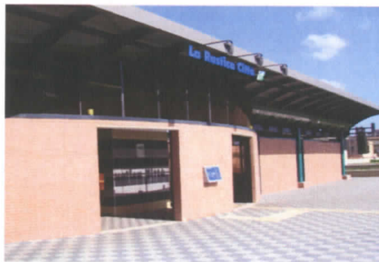
Roma FL2: stazione di "La Rustica Città", pavimentazione in masselli autobloccanti in cls e rivestimento in mattoni di laterizio.
