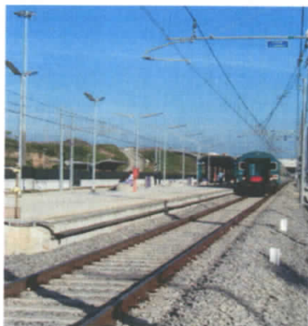
Alcuni esempi di marciapiedi con altezza di 550 mm
