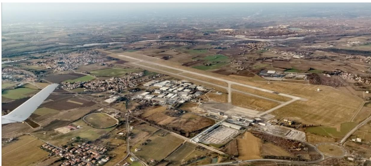
Figura 3 - Vista del sedime aeroportuale
