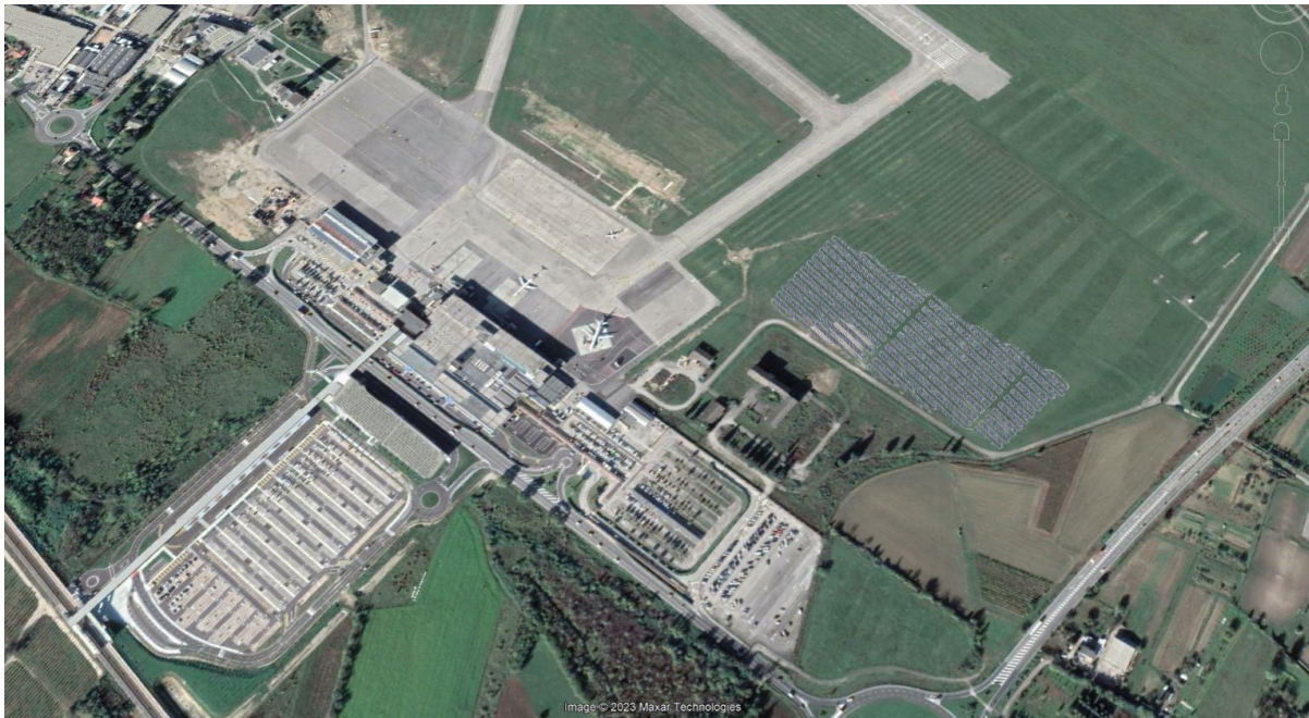
Figura 7 - Vista panoramica dell'impianto fotovoltaico
