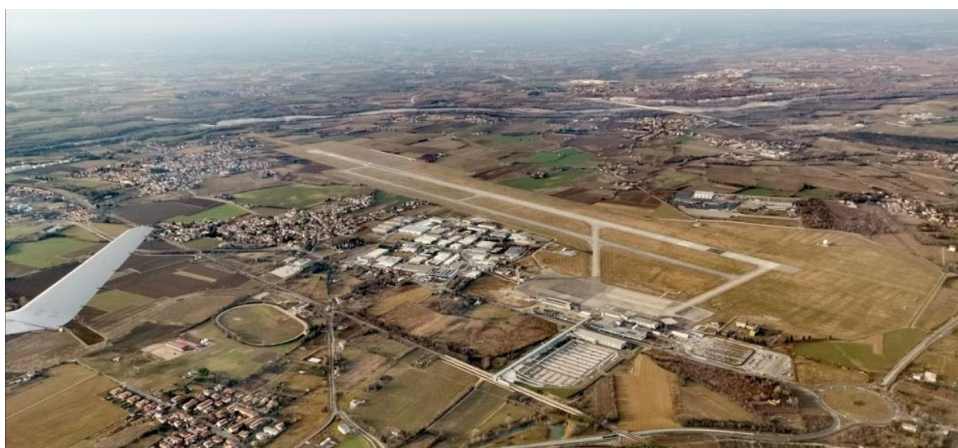
Figura 2 - Vista del sedime aeroportuale
