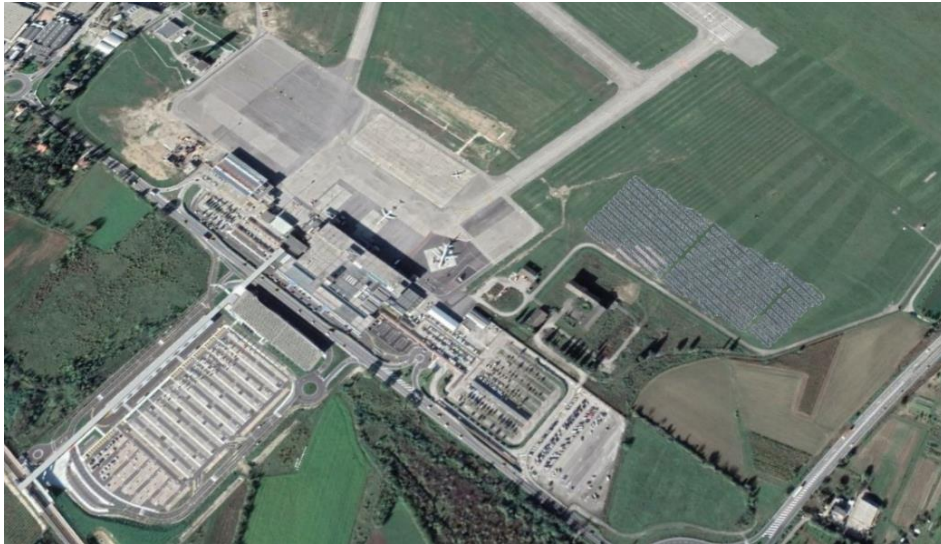
Figura 5 - Vista panoramica dell'impianto fotovoltaico
