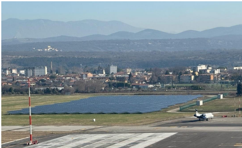
Figura 6 - immagine dell'impianto fotovoltaico air side
